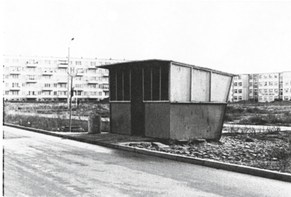
Bild 11: zeigt den Standort des Buswartehäuschen an der Haltestelle W.-I.Lenin-Str./ Hydraulikwerk, aus einer Entfernung von ca. 10 m gesehen.
