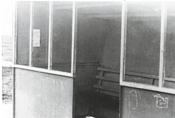
Bild 12: zeigt die Anbringung der Hetzschrift an der linken Seite des Buswartehäuschen in einer Höhe von 135 cm Unterkante und 164,5 cm Oberkante. Die Hetzschrift war uch hier mittels Klebstoff angebracht, der vorher an der Wand verrieben wurde. Die Abtrennung der Hetzschrift bereitete große Schwierigkeiten, da das Papier trocken und fest angeklebt war.
